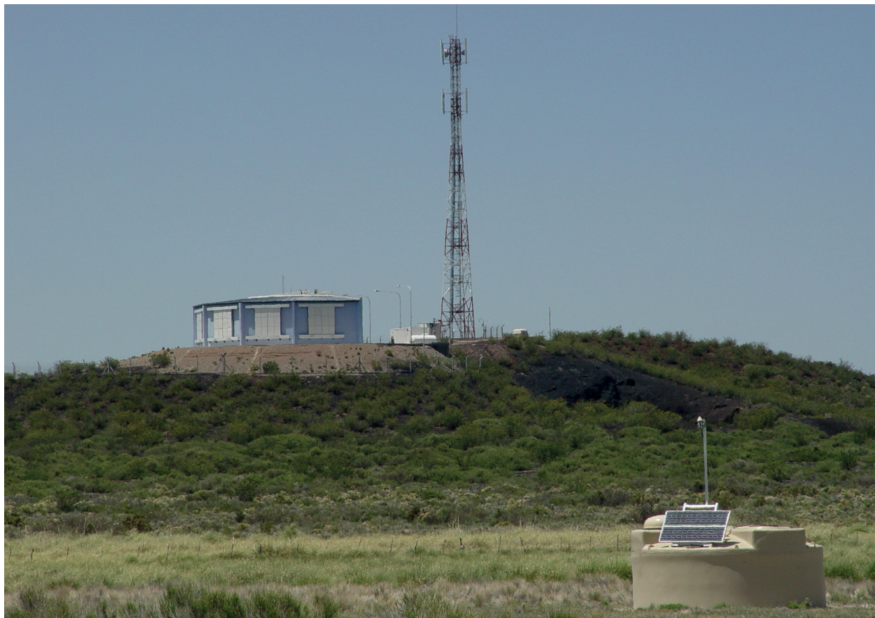
Figuur 1 Deeltjesdetector met op de achtergrond een gebouw met fluorescentietelescopen, onderdeel van het Pierre Auger Observatorium. Foto: Pierre Auger Observatorium.
