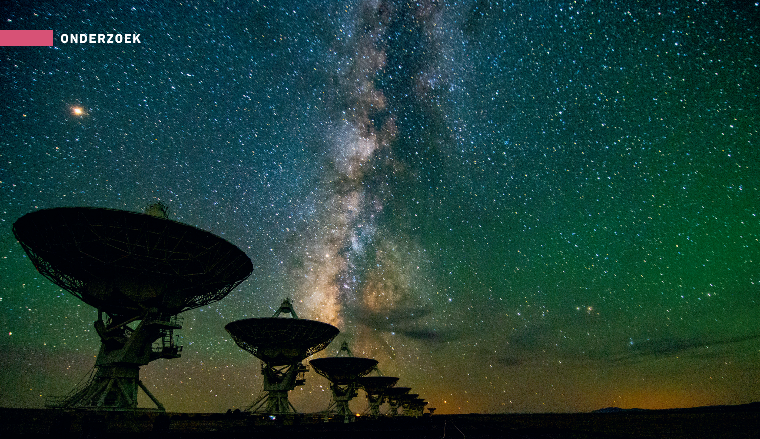
Figuur 4. Een aantal schotels van de Very Large Array in New Mexico in de Verenigde Staten. In totaal bestaat de telescoop uit 27 schotels, ieder met een doorsnede van 25 meter, die alle tegelijk een enkel object aan de sterrenhemel observeren. De sterrenhemel laat de Melkweg zien. Foto: NRAO/AUI/NSF, Jeff Hellerman.
